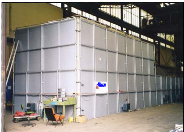
Een MFS-oven in aanbouw. De afmetingen zijn hier 5 x 5 x 15 meter. De complete bouwtijd bedraagt minder dan 10 manuren.
